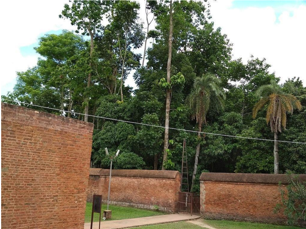
चित्र 7 : बृन्दाबन चंद्र मठ की चारदीवारी में संकरी प्रवेश मार्ग Photo 7: Narrow entry passage on the boundary wall of the Brindaban Chandra's Math
